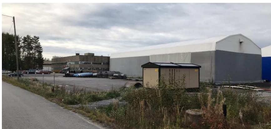
Bild 3. Befintliga industribyggnader inom området.
